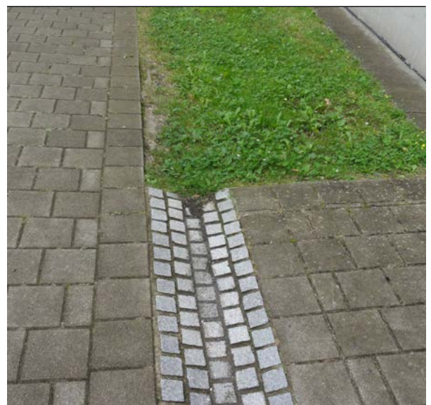
Einfache Maßnahme zur schadlosen Ableitung von Regenwasser
