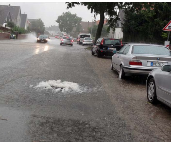
Starke Regenfälle können zur Überlastung der Kanalisation ...
