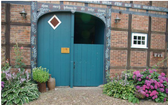
Groot Dör mit Klöntür und Fenster zur Belichtung der Diele
