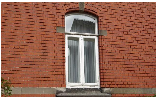
Historisches Fenster mit zwei Flügeln, Oberlicht
