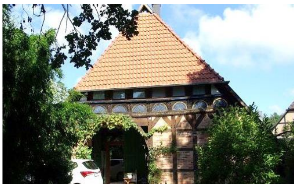
Fachwerk mit Ziegelausmauerung
