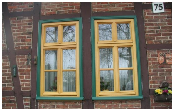
Erneuerte Fenster in Fachwerkgebäude
