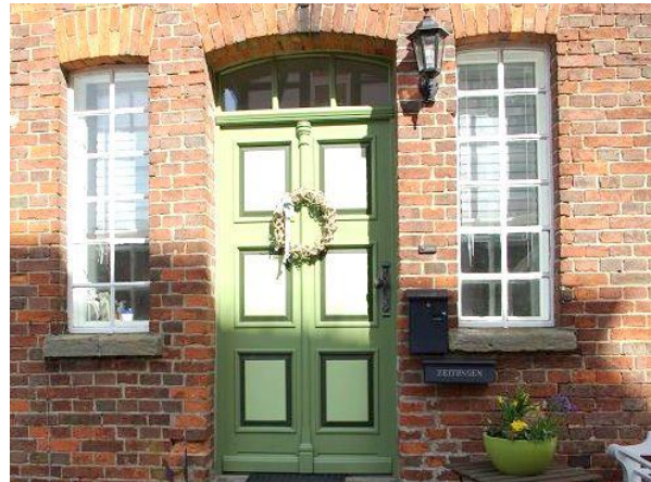
Typisch sind die beidseitigen schmalen Fenster
