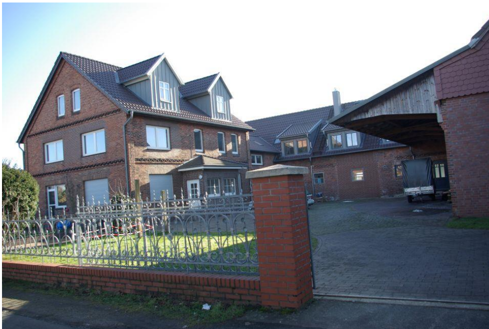
Abbildung 3 Auf der Hofstelle in der Vöhrumer Gartenstraße entsteht ein Wohnprojekt für zwei Familien
