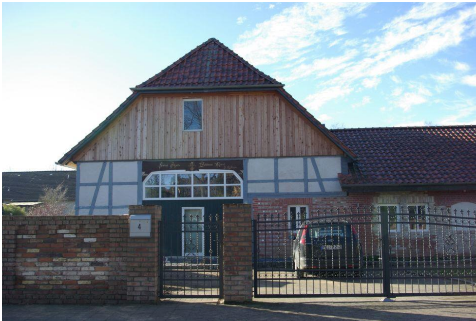
Abbildung 4: Eines der ältesten Fachwerkgebäude in Vöhrum wurde saniert
