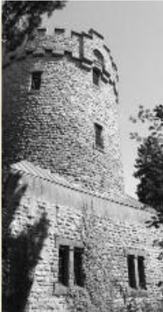
Der Wasserturm im Herzberg
